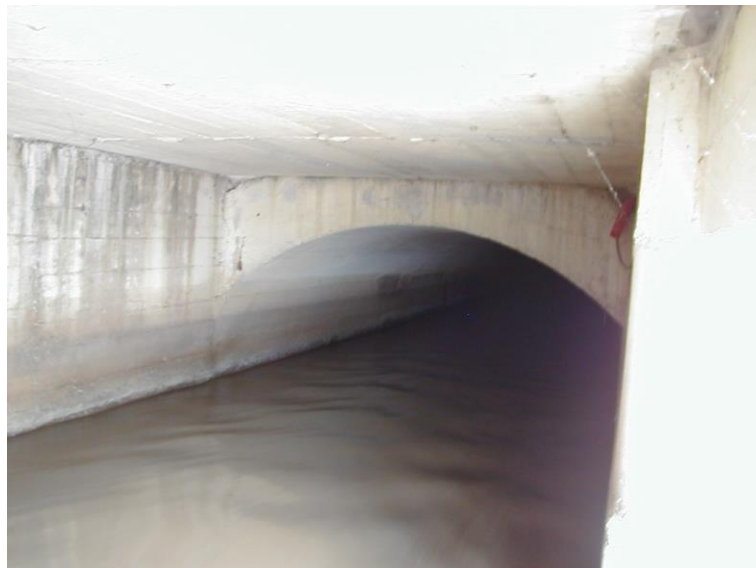
Alcantarillado visitable con caudal alto.
