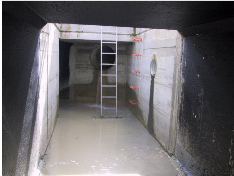
Acceso adecuadamente dimensionado para medios mecánicos
