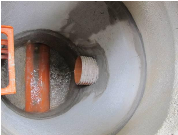
Acometida a pozo con media caña para evitar acumulación de sólidos
