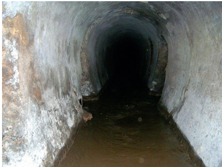
Nudo en alcantarillado visitable sin señalizar
