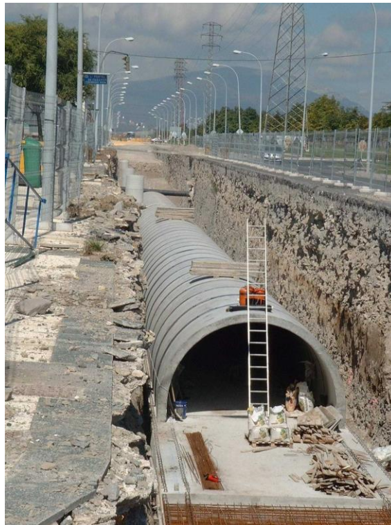
Alcantarillado visible en ejecución
