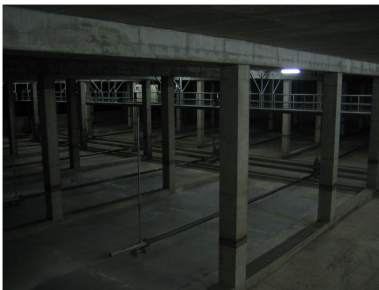
Tanque de tormentas con accesos que no permiten el empleo de medios mecánicos
